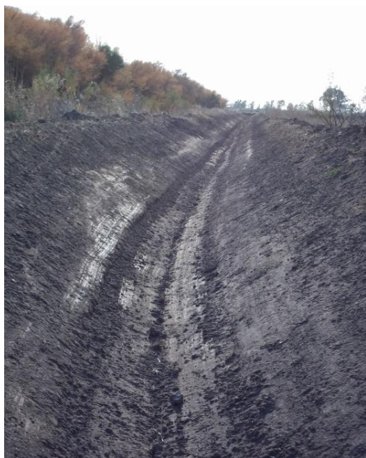
Fig. 1.- Acequia limpia con previa pasada de zanjador. Fecha 23-08-2011.
